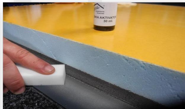
Nach der Aktivierung des Aluminiums tragen wir das Präparat SIKA PRIMER 206G+P auf die zu verklebenden Elementen auf. Dabei achten wir darauf, dass die übrigen Paneel Elemente oder Flügel nicht verschmutzt werden.
