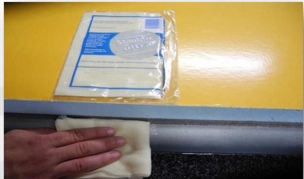
Anschließend wischen wir mit einem Schwamm SIKA POWER CLEAN AID und dem Präparat SIKA AKTIVATOR PRO die Oberfläche des Flügels und des Blechs an der Klebestelle ab.
