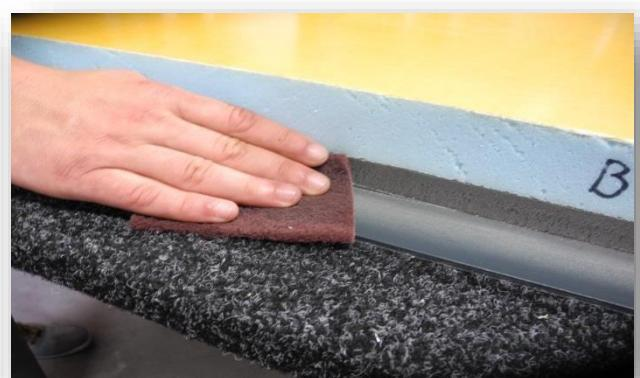
Die Oberfläche muss nach dem Anrauen sorgfältig mit einem feuchten Tuch vom Staub gereinigt werden
